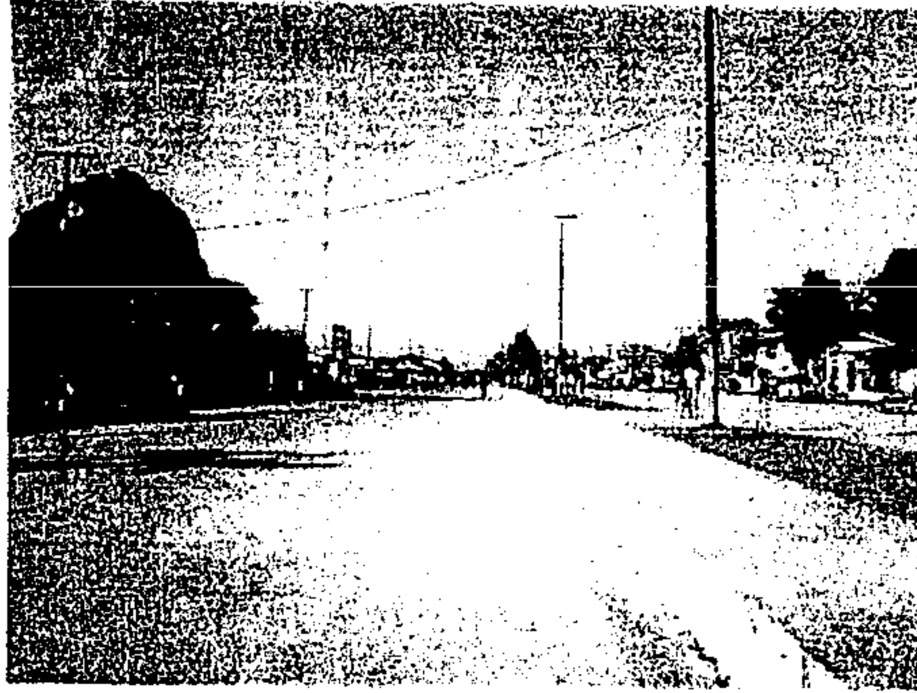
FOTO 01: CONCLUSÃO DA INFRA-ESTRUTURA URBANA - Vista da pavimentação da Avenida Rio Branco. No detalhe, a pavimentação em concreto, e execução de canteiro em concreto simples.
