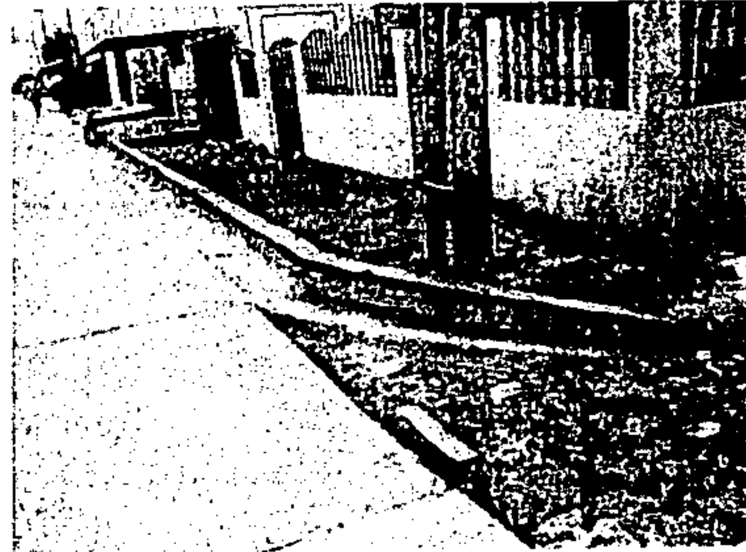
Drenagem superficial: meio-fio e sarjeta
