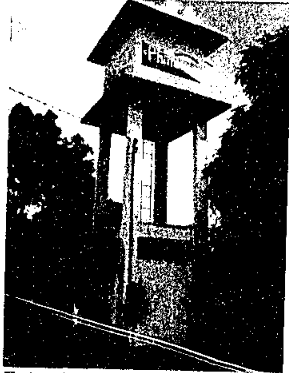
Foto 01: Reservatório elevado em concreto.
