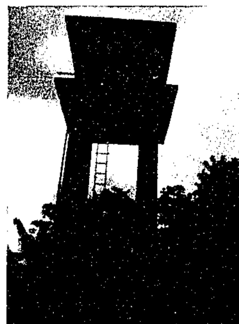
Foto 16: Reservatório elevado em concreto.
