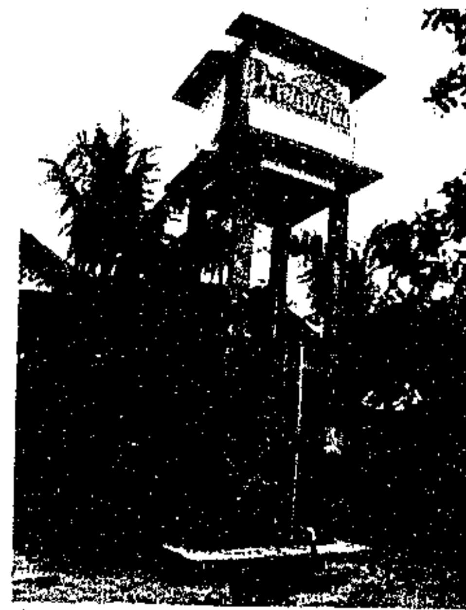
Foto 10: Reservatório elevado em concreto.
